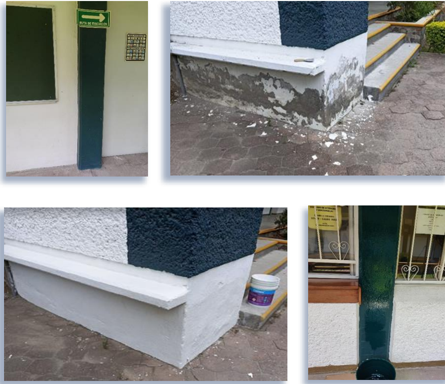
Repintado de paredes interiores dentro del edificio C, aula “Archivo de Concentración.”
