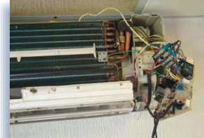
Mantenimiento correctivo a evaporador de aire acondicionado del salón G1
