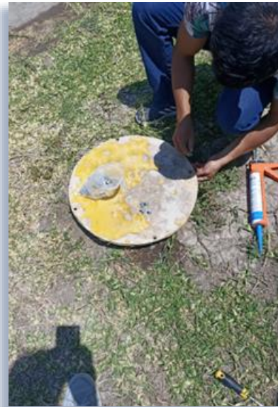
Sellado de tapa de la planta de tratamiento de las aguas residuales.
