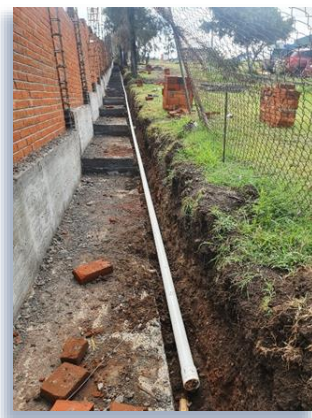
Colocación de tubería de pvc de 2 1/2 para el llenado de la cisterna del edificio K
