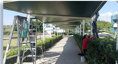
Mantenimiento de reparación de lona en techado de pasillo de andadores, que consistió en retiro de partes dañadas y colocación de lona nueva mediante proceso de termofusión.
