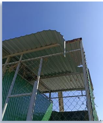
Mantenimiento de reparación de lona en techado de pasillo de andadores, que consistió en retiro de partes dañadas y colocación de lona nueva mediante proceso de termofusión.
