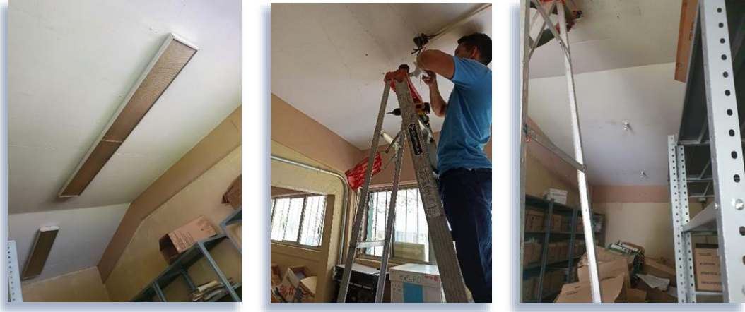
Mantenimiento a lámpara suburbana de muros laterales del edificio I, cambio de focos y fotoceldas.
