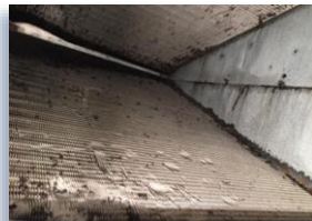
Mantenimiento correctivo a evaporador de aire acondicionado del salón G1
