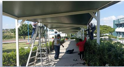
Mantenimiento de reparación de lona en techado de pasillo de andadores, que consistió en retiro de partes dañadas y colocación de lona nueva mediante proceso de termofusión.
