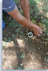
Colocación de tubería de pvc de 2 1/2 para el llenado de la cisterna del edificio K
