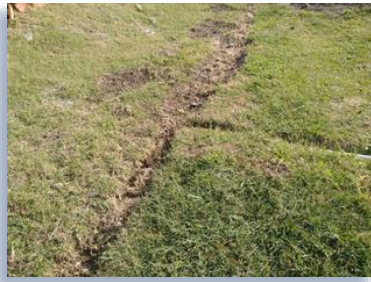
Colocación de tubería de pvc de 2 1/2 para el llenado de la cisterna del edificio K
