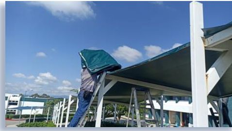
Colocación de repisas en las oficinas de extraescolares en el edificio D
