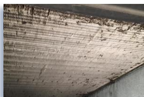
Mantenimiento correctivo a evaporador de aire acondicionado del salón G1
