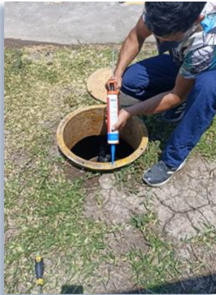
Sellado de tapa de la planta de tratamiento de las aguas residuales.
